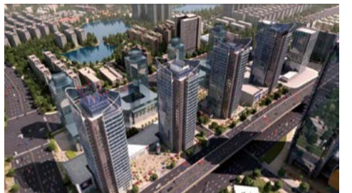
南京长江航运中心项目
