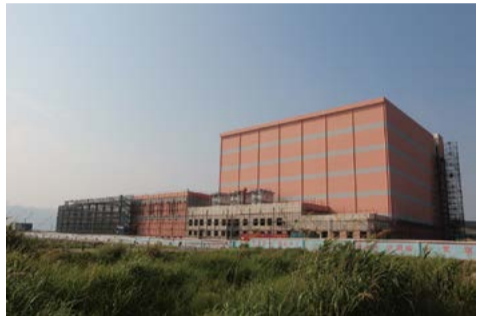
浙江省象山水产中心冷库项目
